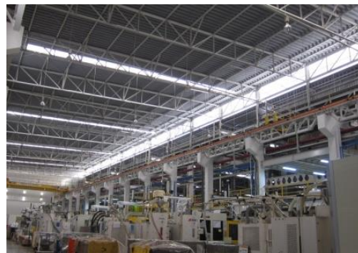
自然換気・自然採光を採用した省エネルギー工場
